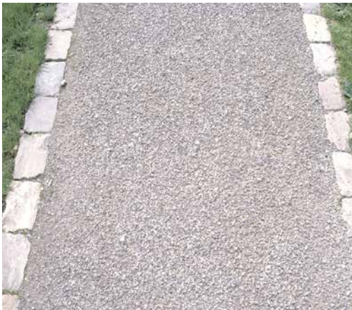
halfverhard pad (Stabilizer) opgesloten met natuursteen kei (Zweeds graniet)
