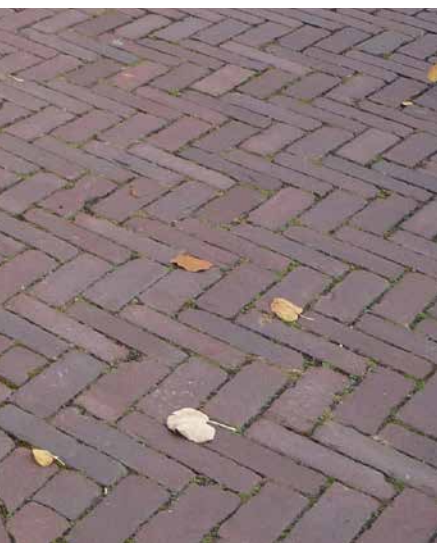
hergebruik van klinkers DF roodbruin, keperverband
