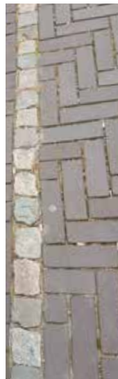
Belijning weg/ molgoot met natuursteen n.t.b.
