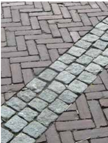
Belijning weg/ molgoot met natuursteen n.t.b. (gezaagd zweeds / portugees graniet/ hardsteen)
