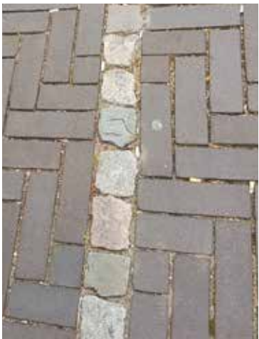
Belijning weg/ molgoot met natuursteen n.t.b. (gezaagd zweeds / portugees graniet/ hardsteen)
