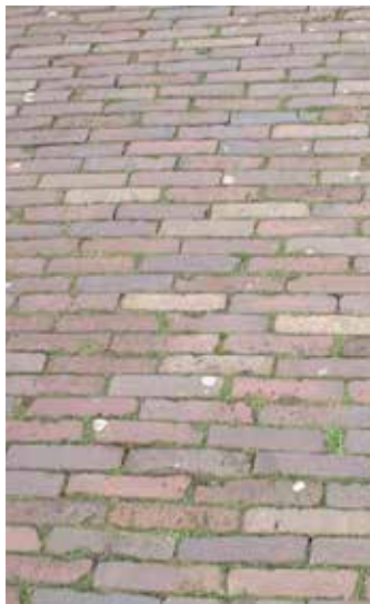
klinkers WF roodbruin, halfsteens verband,
