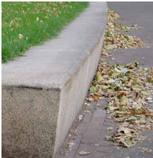
Plateau onder kiosk baksteen met natuurstenen afdekking of geheel uit natuursteen
