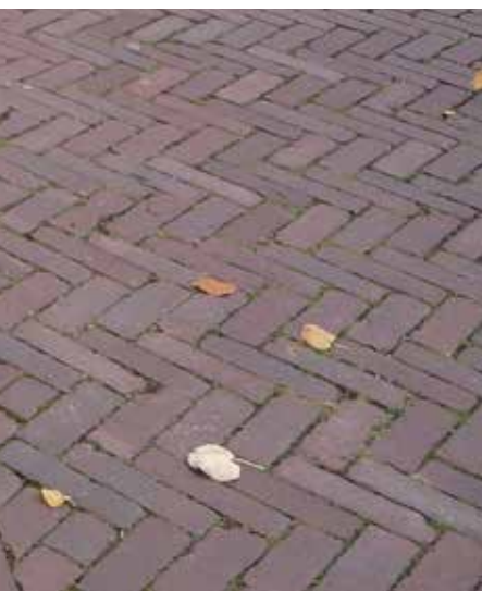
hergebruik van klinkers DF roodbruin, keperverband
