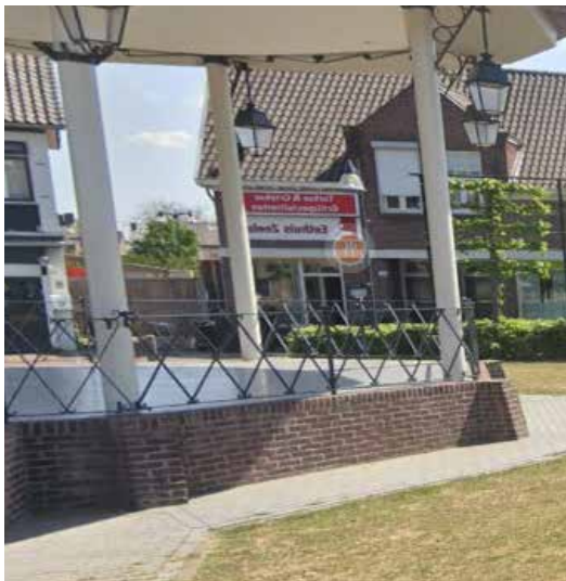
Plateau onder kiosk baksteen met natuurstenen afdekking of geheel uit natuursteen
