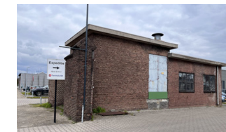
Afbeelding 21. Monumentaal Transformatorhuisje, Donk
