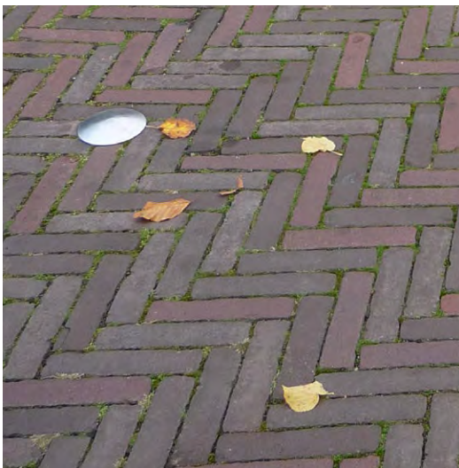
pleinruimte/ voetgangersgebied in klinkerverharding waaltjes rood- bruin, elleboog verband,
