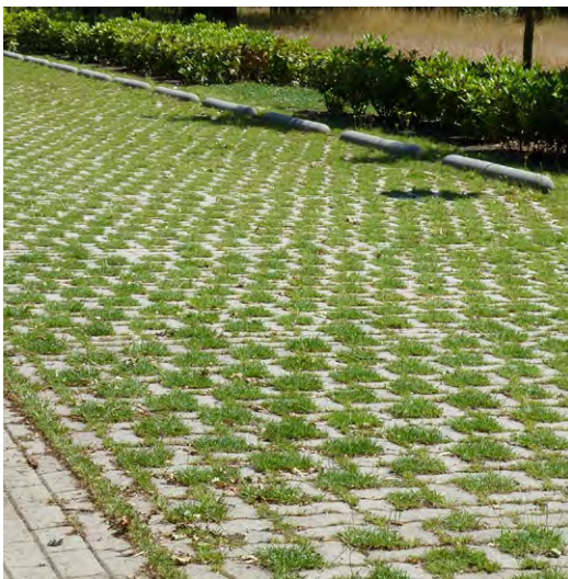
Parkeren bij school/Moreeshof/ Klumper: Open verharding met gras BSS KF in molenwiekverband (hergebruik)
