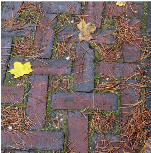
Parkeervakken ten oosten Bavariacafé: Open verharding met gras Klinkerverharding KF (hergebruik), molenwiekverband
