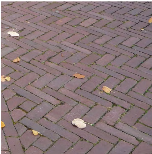
rijwegen plein: hergebruik van klinkerverharding DF roodbruin, keperverband
